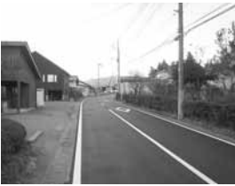
▲補修された町道北下・長岡線
