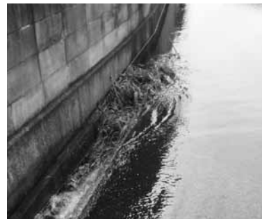
水路が詰まっている様子
