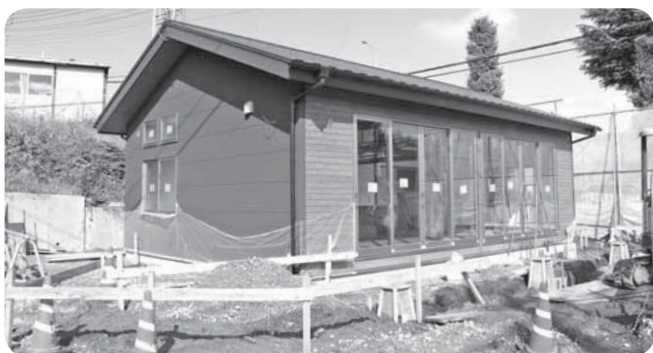
▲改修工事の進む地域福祉交流拠点施設
