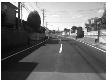
▲補修工事が完了した町道北下・長岡線
