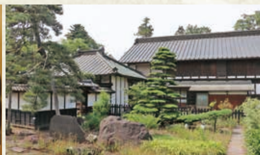
右奥の主屋は江戸中期以降に建てられたものとみられている。左手前の書院は県内屈指の規模で、江戸後期に建てられたもの
