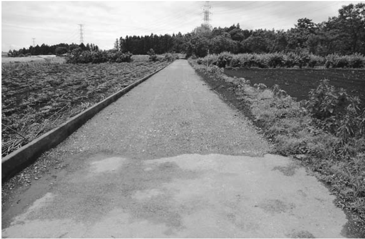
待たれる道路の延伸 上野原南北線
