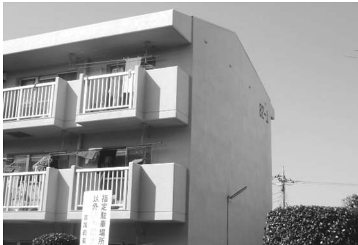
本宿団地長寿命化工事 防水・側壁改修
