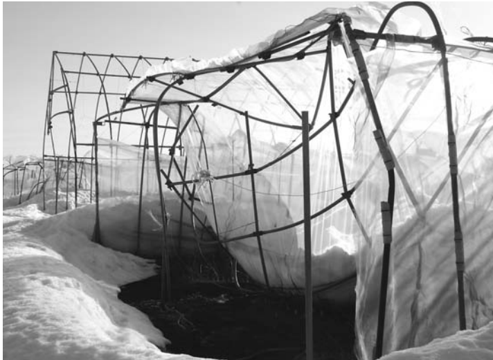
雪害を受けたビニールハウス
