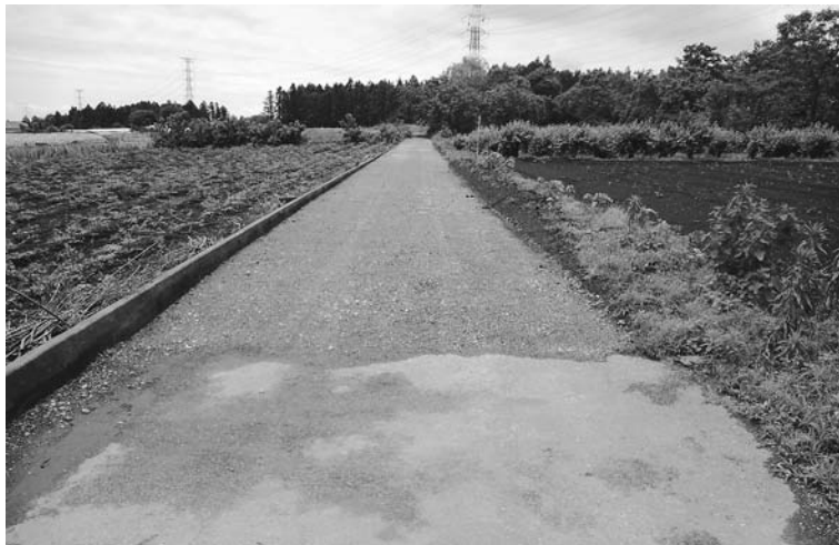
待たれる道路の延伸 上野原南北線
