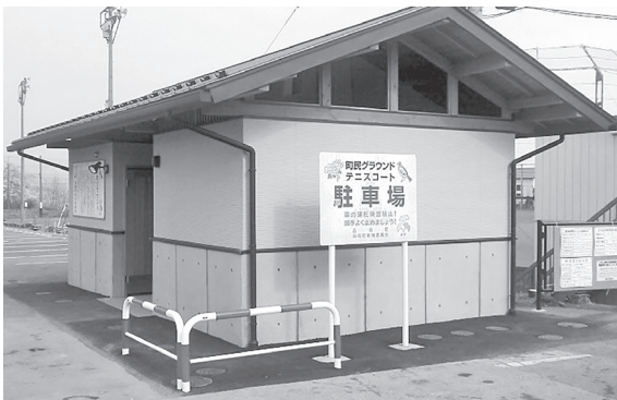
新築された水洗トイレ（町民グラウンド）
