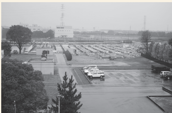
県央水質浄化センター（玉村町）
