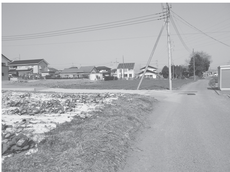
側溝がほしい道路
