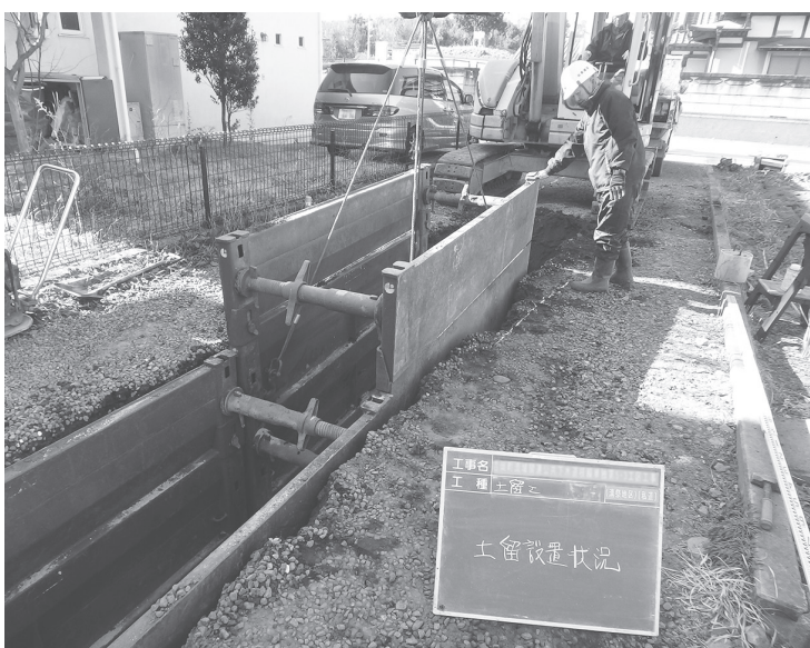
5カ年計画で石綿管布設替え工事が進む
