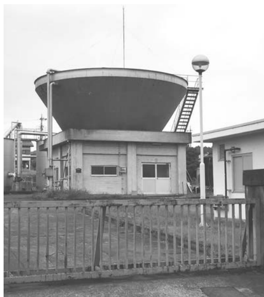
老朽化が進む第一浄水場
