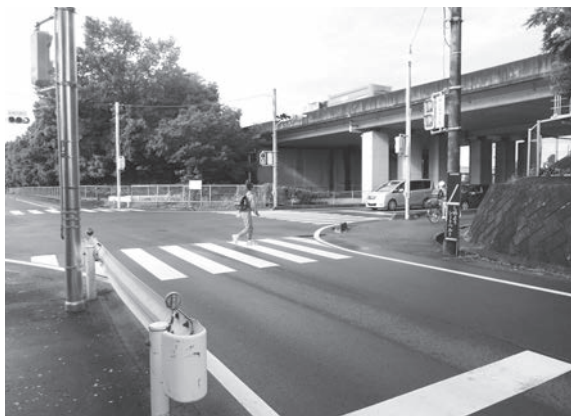
歩行者用信号機が設置された宮田沼橋信号機
