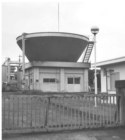
老朽化が進む第一浄水場
