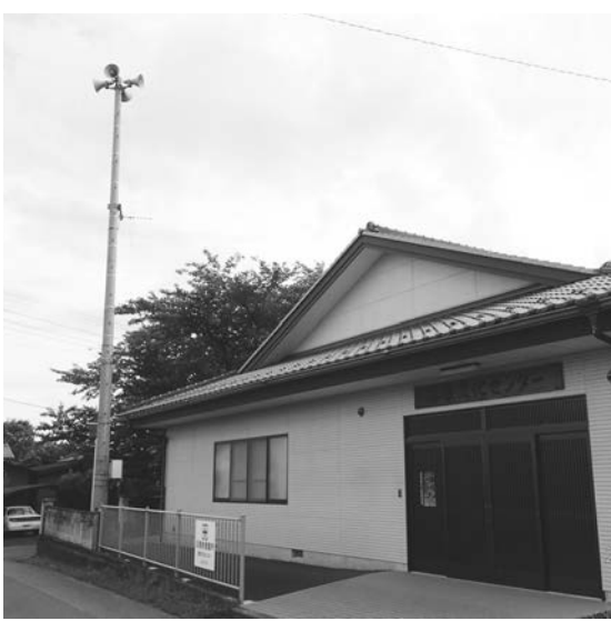
デジタル化が予定されている防災無線(漆原文化センター)
