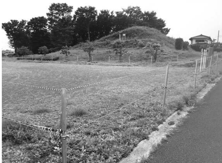
基準値を超えるフッ素が検出され、立ち入り禁止となっているが(南下古墳公園駐車場)
