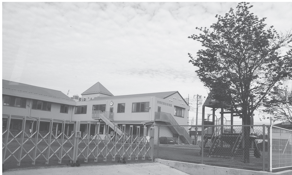
平成27年10月に完成した第四保育園新園舎
