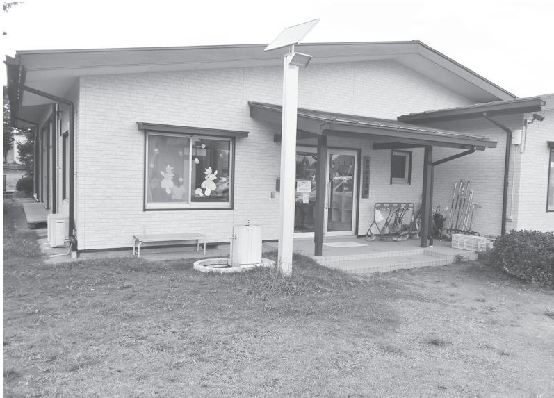
耐震工事が済んだ児童館
