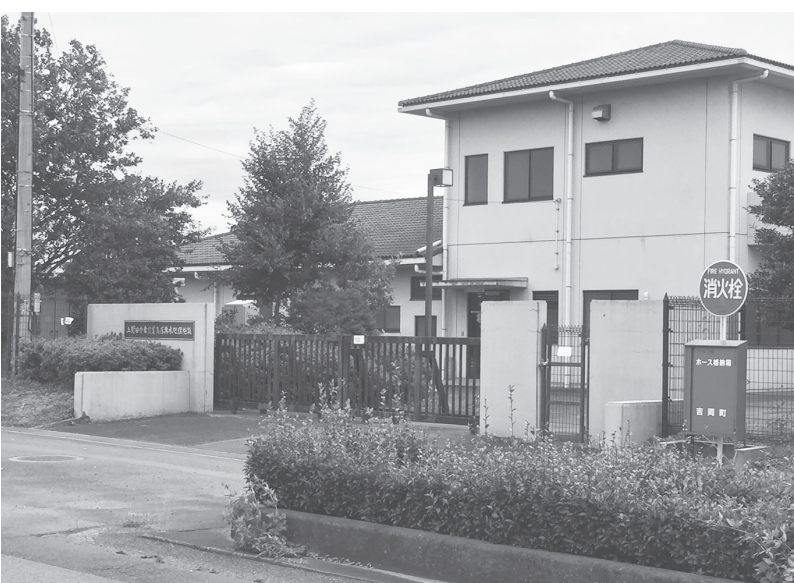
今後、公共下水道への接続が期待されている農業集落排水
