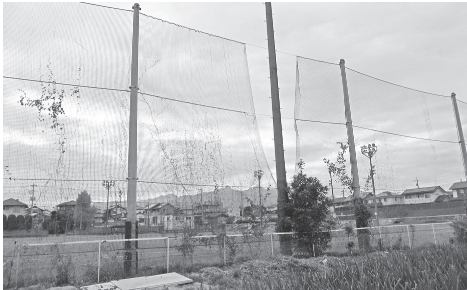
改修予定の町民グラウンドフェンス
