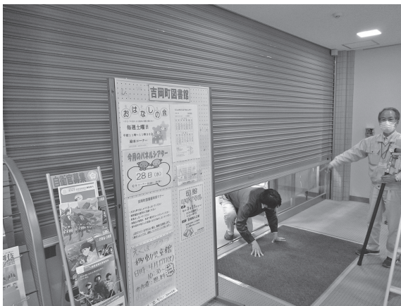
危害防止装置のついた防火シャッター (人がはさまる危険を回避)
