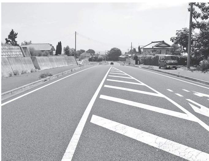
土壌汚染が認められたが、地下水への影響はなかった宮田大藪線
