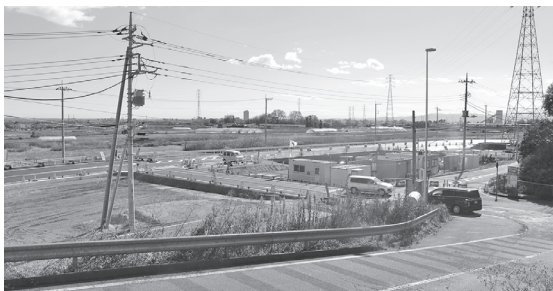
平成32年度の供用開始に向け工事が進む駒寄スマートIC
