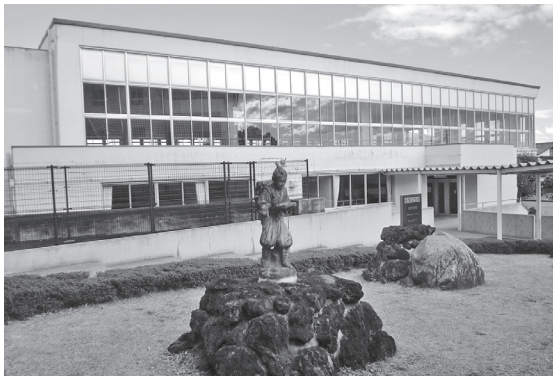
入学式後、解体および新築工事始まる駒小体育館
