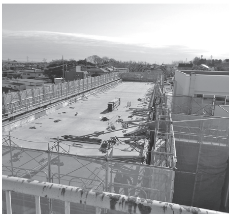
順調に工事が進んでいる
