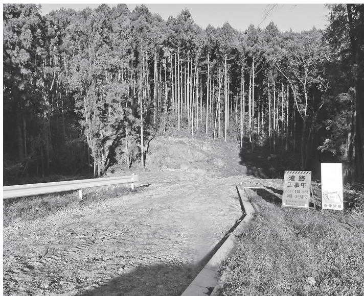
令和2年度完成を目指して工事中（林道栗籠・井堤線）
