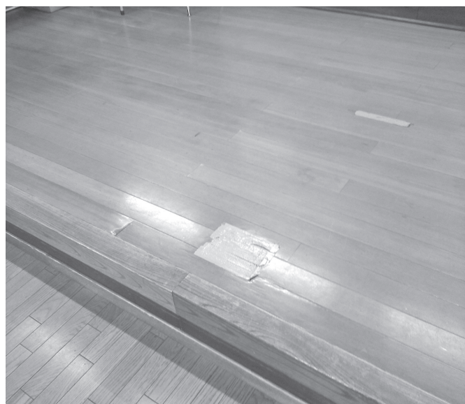
建物の老朽化対策が求められる (児童館)
