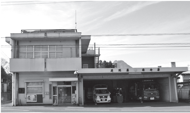
老朽化により移転計画が進んでいる(南分署)
