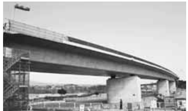
建設中の前橋・渋川バイパス（国道17号線）
