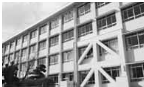
明小校舎耐震補強工事後
