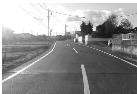
▲舗装された北下地内の町道北下・長岡線
