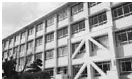
明小校舎耐震補強工事後
