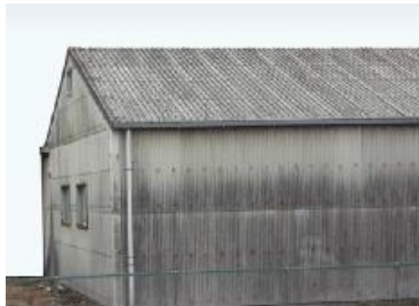
石綿含有スレート波板（屋根・外壁）
