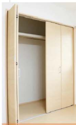
④襖全部を撤去、木製開き戸等として使いやすい収納に更新
