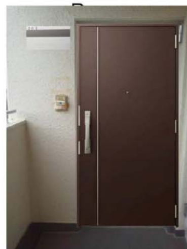
⑨玄関ドアを断熱ドアに更新
