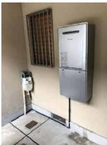
⑥バランス釜の廃止・給湯器更新（管理上は屋外壁掛型給湯器の設置が望ましい）
