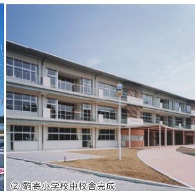
② 駒寄小学校中学校舎完成
