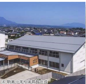
④ 駒寄小学校体育館完成
