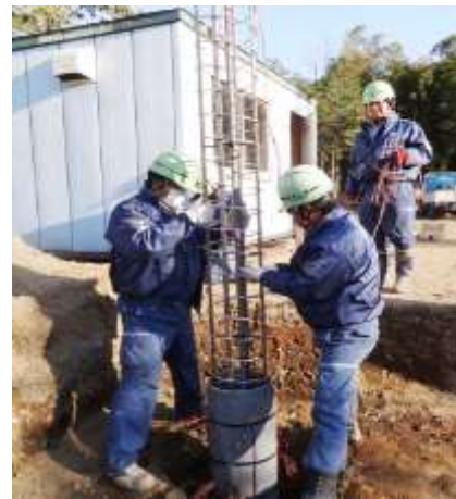
図 7 建柱車による地中熱交換器施工
