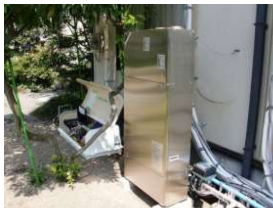
一次側ヘッダーとヒートポンプ（右）
