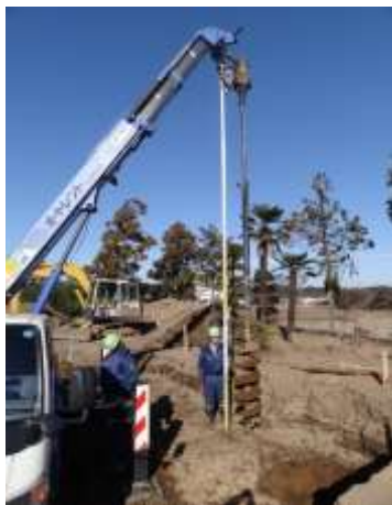
図 7 建柱車による地中熱交換器施工
