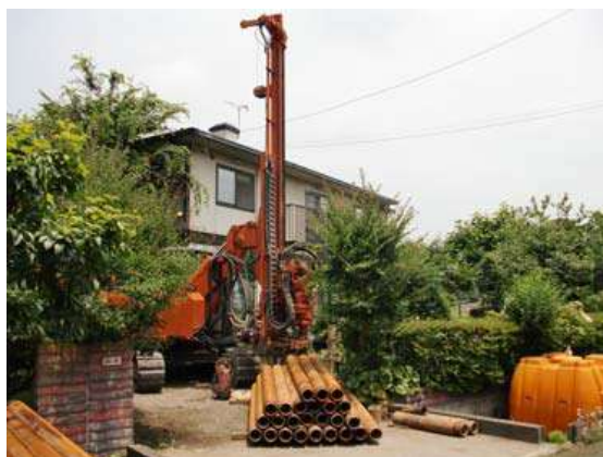
地中熱交換井の施工（ソニックドリル）
