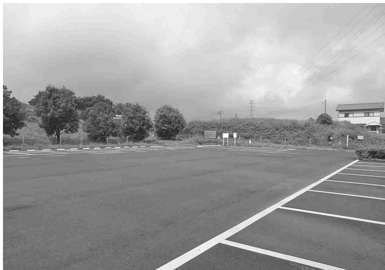
アスファルトで被覆されたが、スラグ問題の根本的な解決には至っていない (南下古墳公園駐車場)
