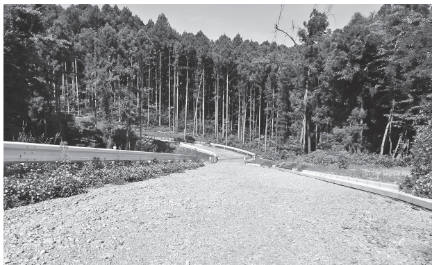
舗装工事は来年2月末に完成予定（林道栗籠・井堤線）
