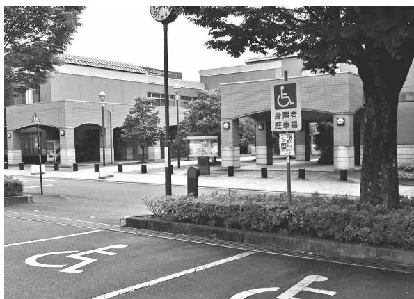
現在、文化センターには隣接する障害者等用駐車場がない
