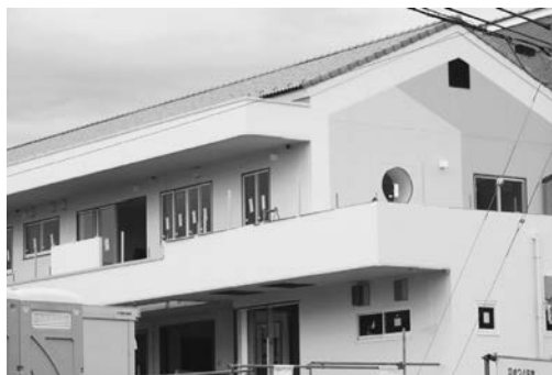
建設中の第二保育園
