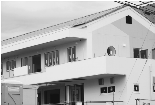
建設中の第二保育園
