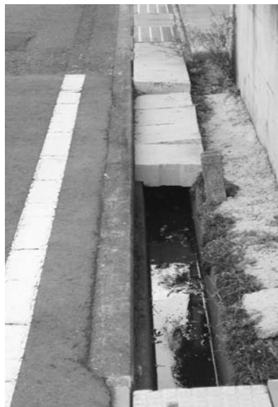
町民グラウンド西の側溝
