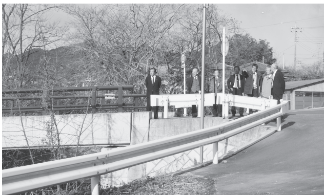
陽なた坂橋付近
