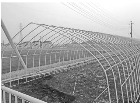
雪害復旧 ハウスの建設
