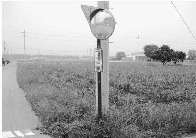
錆びついたカーブミラー
