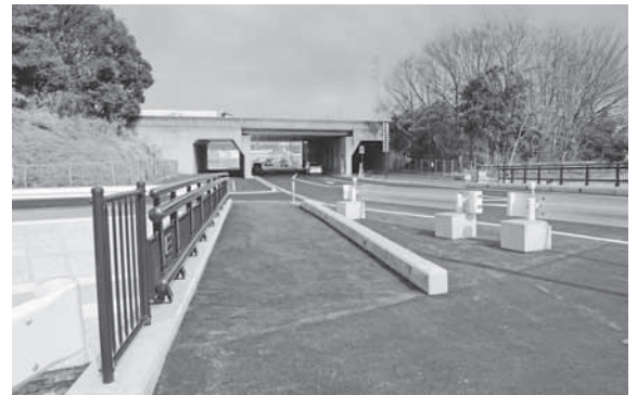
大型車対応化のための改修予定地
