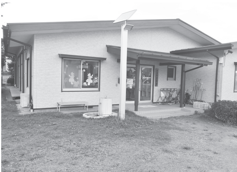
耐震工事が済んだ児童館
