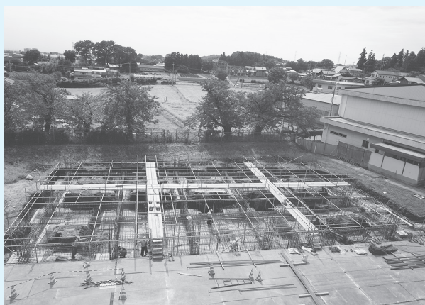
校舎の増築工事が進む明治小学校
