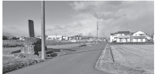
商業誘致エリアにはジョイフル本田の出店が 計画されている（道路改良工事予定地）
