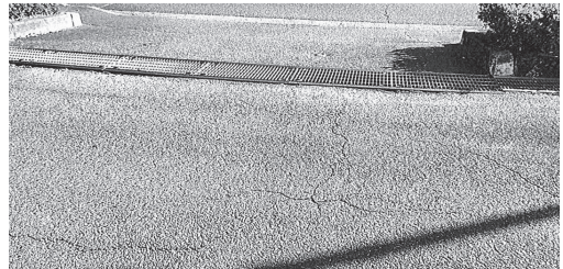
網目の間隔が大きく、車いすの車輪がはまる などの問題があった（グレーチング蓋）
