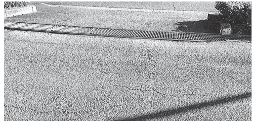
網目の間隔が大きく、車いすの車輪がはまる などの問題があった（グレーチング蓋）
