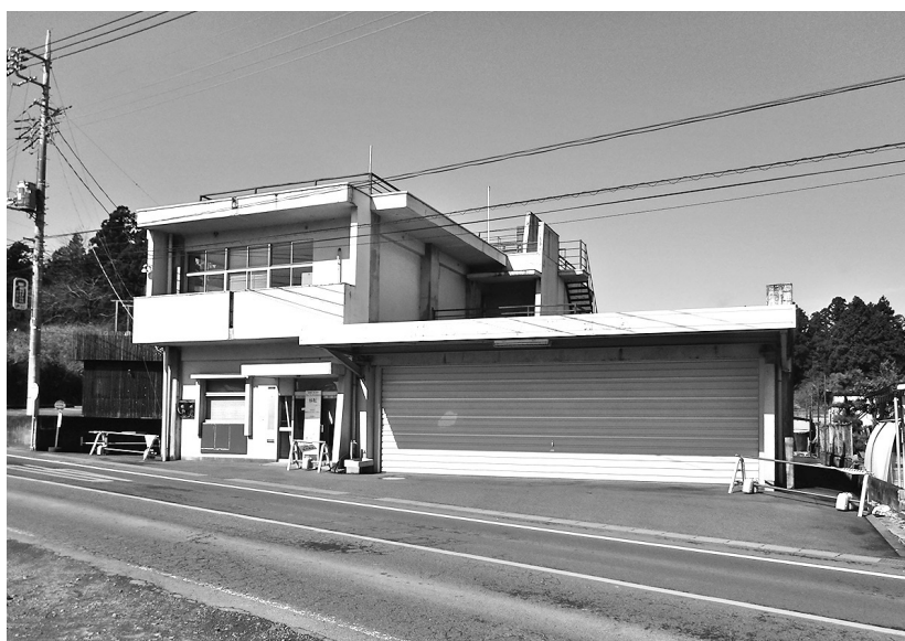
解体が予定される旧渋川広域消防本部南分署
