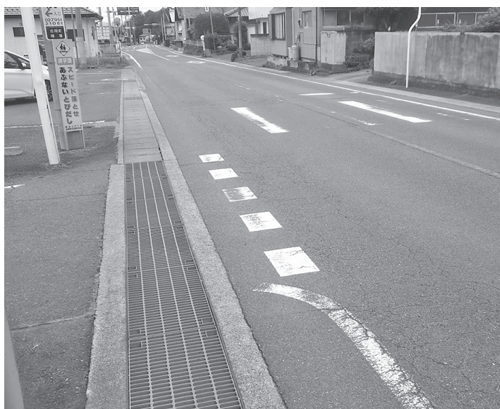
白線が消えている横断歩道（町道小倉・陣場線）
