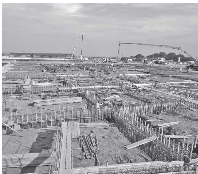
店舗建設が進むジョイフル本田出店地
