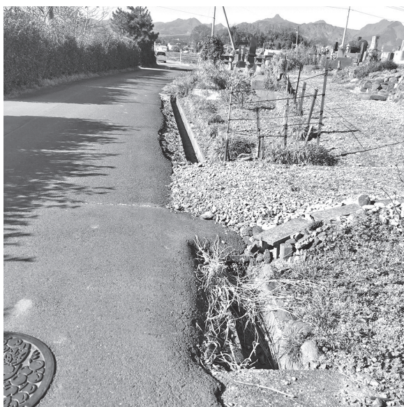
要望箇所の早期改善を（陣場地内）
