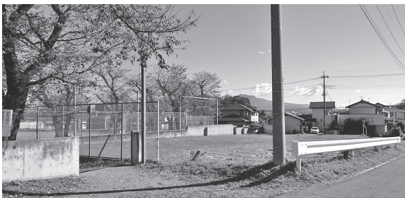
令和6年度中に工事完了予定（吉中校庭拡張予定地）
