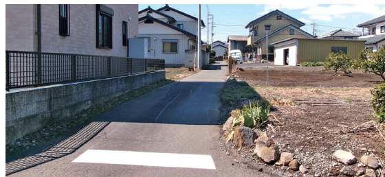
拡幅が望まれる狭小道路
