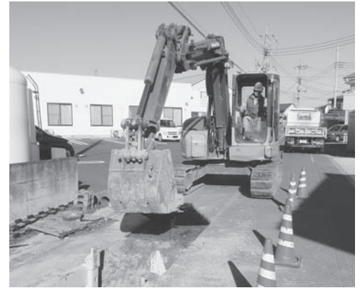
公共下水道工事（駒寄台地区）
